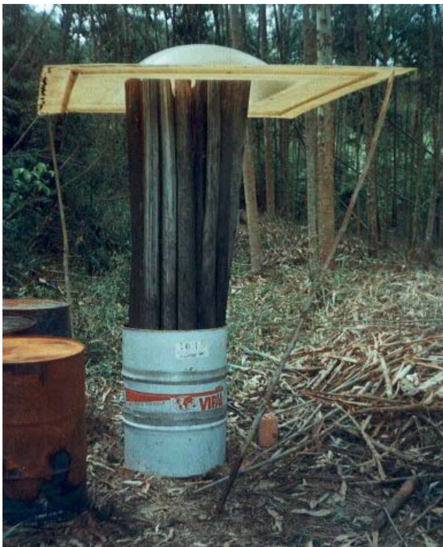
Figura 8. Mourões em tratamento pelo processo de Substituição de Seiva. Neste caso os mourões estão muito justapostos, impedindo a ventilação adequada daqueles colocados no centro do tambor e que receberão produtos preservativos em quantidade inferior à recomendada.
